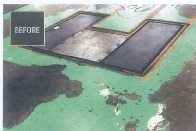
油が浸透した整備工場のピット床...
